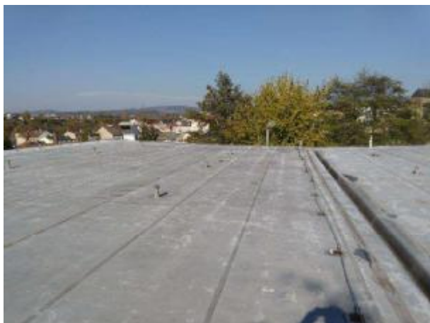
Foto 4 – rozsah degradace v ploše folie
