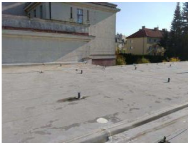
Foto 5 – rozsah degradace v ploše folie
